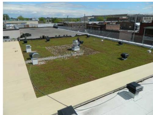
Les membranes nécessaires au support de la végétation ont par la suite été installées sur cette toiture, permettant un développement adéquat des végétaux. La toiture verte de type extensive a accueillie, au mois de mai 2013, 278 m<sup>2</sup> de plantes succulentes, grâce à une mobilisation communautaire qui a assuré la plantation. À noter que la toiture verte
